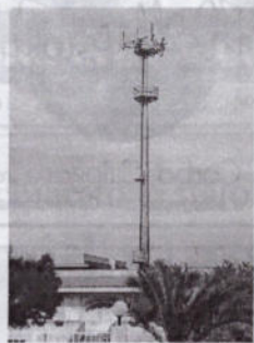
misurazioni, viene abbassata la potenza di emissione. Per l'assenza di campo per i telefonini GSM a Mar-
